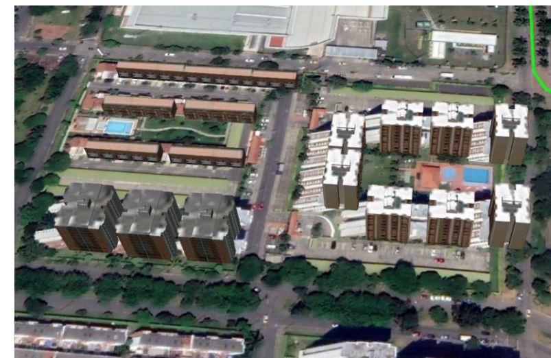
Vista típica 3d de edificios en la zona Fuente Google Earth.
