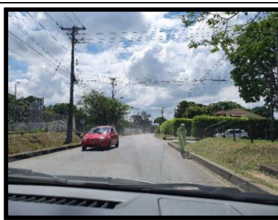
Figura 4 calles sin aceras.
