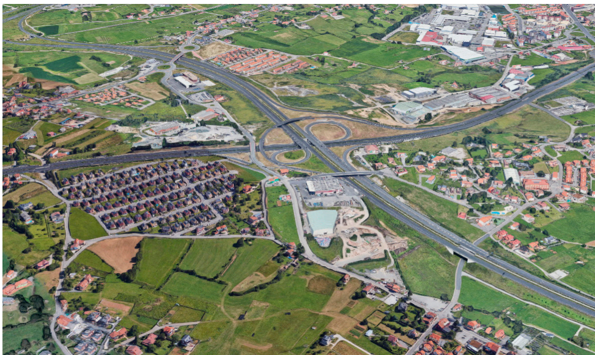
Figura 6. Cruce entre la A-67 y la A-30 cerca de Caicedo. Fuente: Google Earth.
