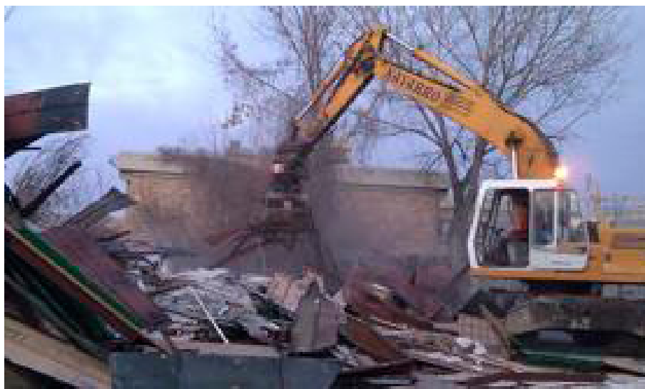
Imagen 2. Derribo de las últimas dos viviendas de El Tejerín (Segovia), el 11 de junio de 2010. Imagen tomada de la Fundación secretariado Gitano 4 .
