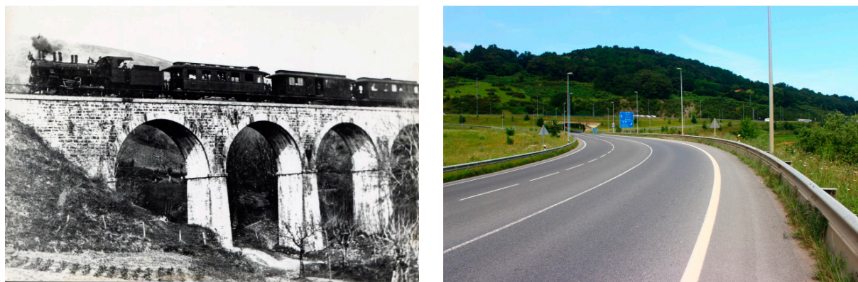
Figura 3. En la foto de la izquierda aparece el antiguo puente del Plazaola (hoy en día derruido como consecuencia de la construcción del acceso sur de Urnieta a la A-15 (Fotografía de la Izquierda). Fotografía de la izquierda del archivo municipal de Urnieta y la de la derecha de los autores.
