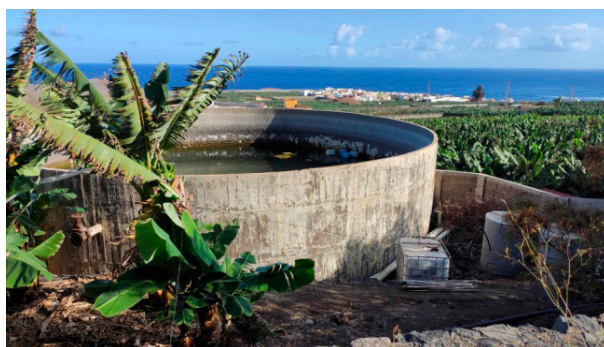
Figura 1. Depósito de agua para riego. (Chaxiraxi Siverio Arteaga).
