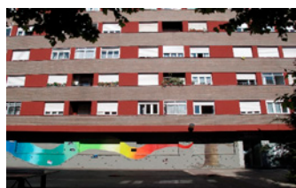
Tratamiento unificado de color en fachada en el Pilar (Vitoria-Gasteiz).
