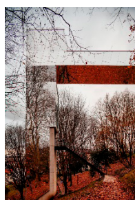
Disposición en ladera de ascensor en Alaberga (Errenteria). Fuente: Aitori Estévez
