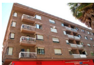
Fachada original sin alteraciones volumétricas en balcones.
